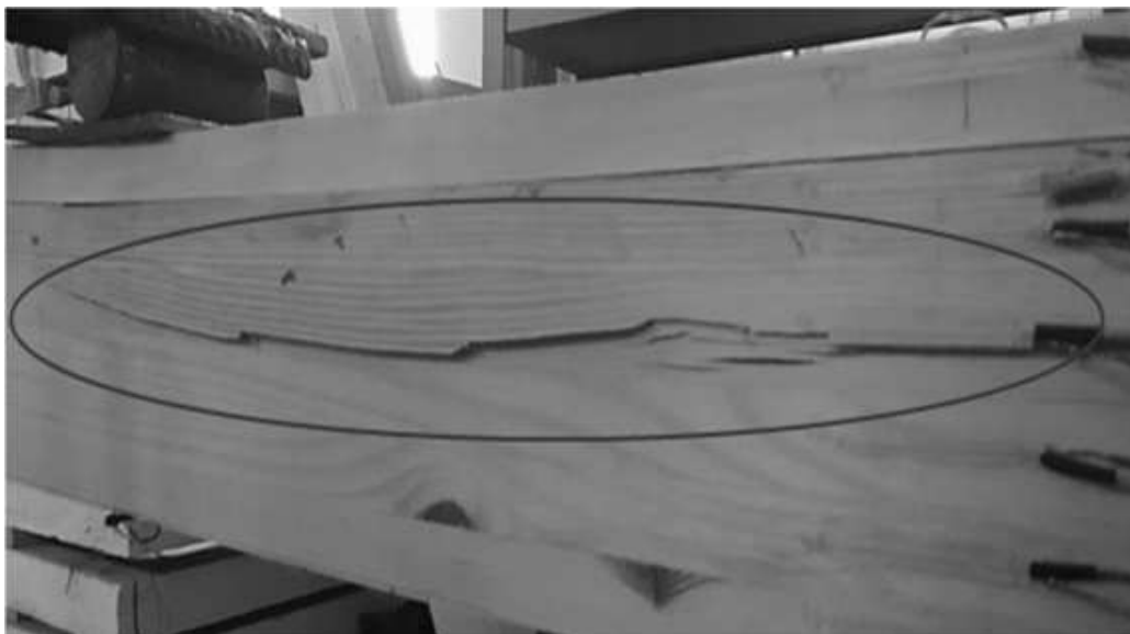
Рис.7. Руйнування балки з клеєної деревини всередині прольоту від дотичних напружень
