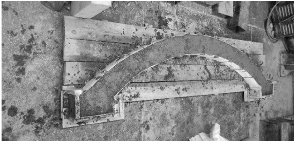
Рис. 2. Залізобетонна арка в процесі виготовлення
