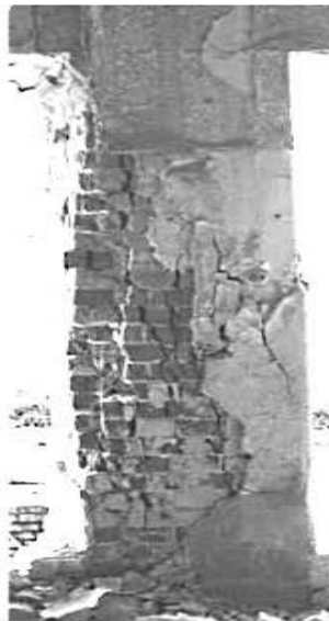
Рис. 4. Характер руйнування цегляних простінків від зрізу за похилою площиною (а) та кінематично можлива схема (б)
