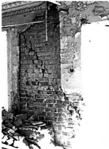
Рис. 4. Характер руйнування цегляних простінків від зрізу за похилою площиною (а) та кінематично можлива схема (б)
