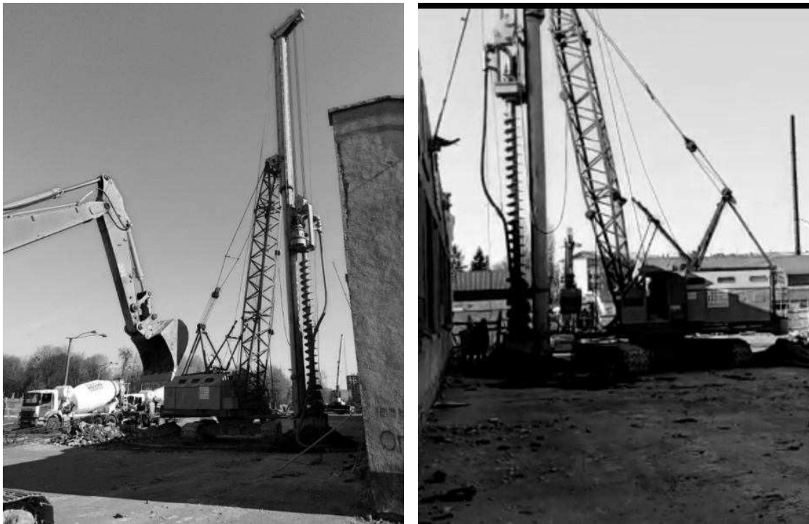
Рис. 2. Установка для буріння та бетонування паль.
