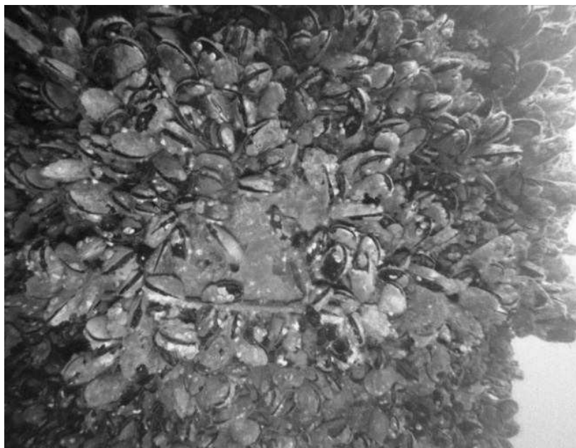
Рис. 4. Підводна частина палі до очищення від мідій
