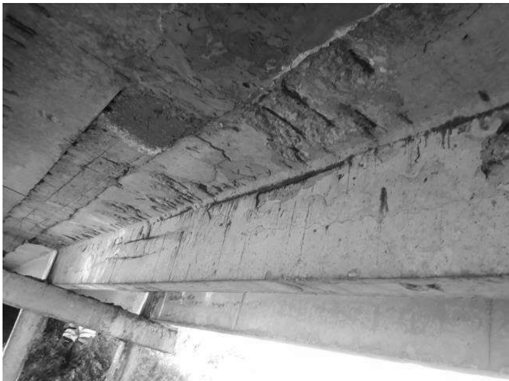
Фото 1. Прогонні конструкції моста
