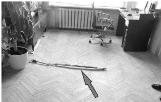
Рис. 7. Підлога у приміщенні над зоною пожежі (прогин підлоги)
