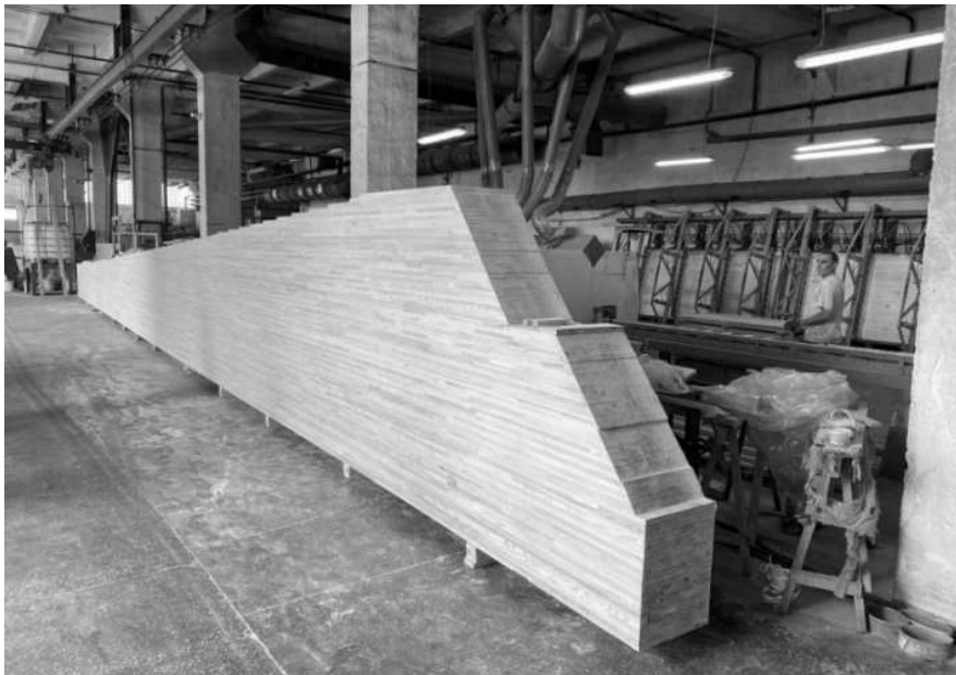
Рис. 3. Виготовлення дерев'яних конструкцій на підприємстві.
