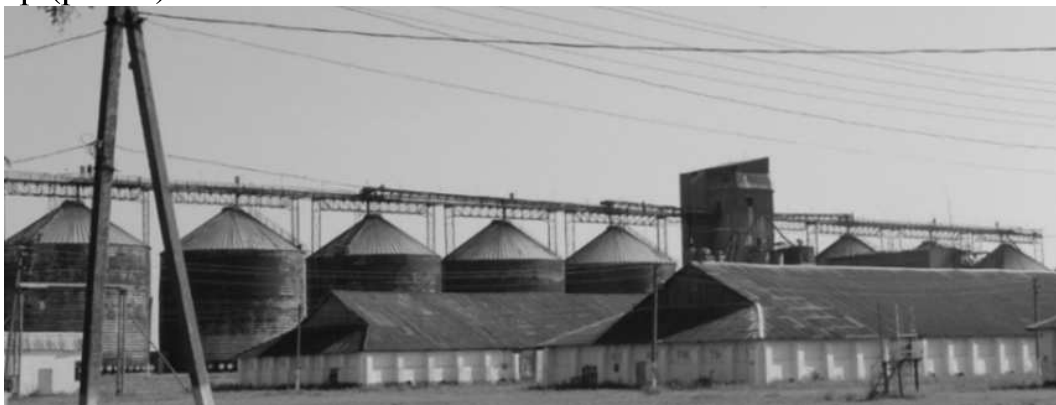
Рис. 2. Силосний комплекс для зберігання зерна ( Запорізька обл., 2021р.)
