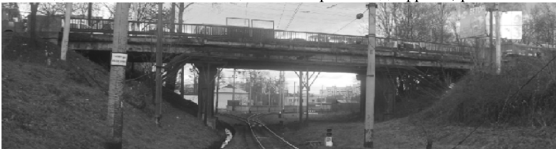
Рис. 1. Загальний вид шляхопроводу
