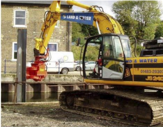
Рис. 1. Занурення шпунта вібраційним методом.
