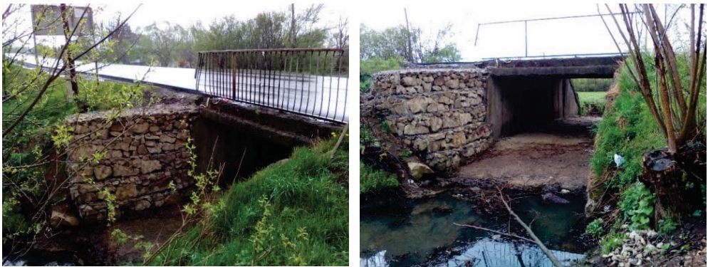
Рис. 2. Загальний вид моста із вхідного отвору
