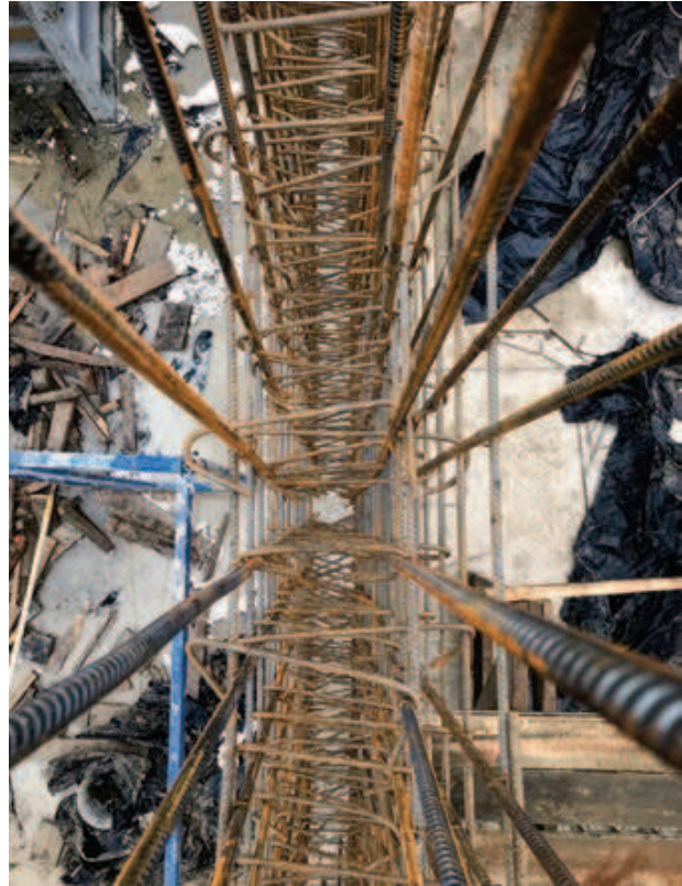
Рис. 3. Фрагмент армування монолітних стін укриття Беручи до уваги п.14.2.3.6 [1] виконувалось конструювання плити перекриття над укриттям (рис. 4).
