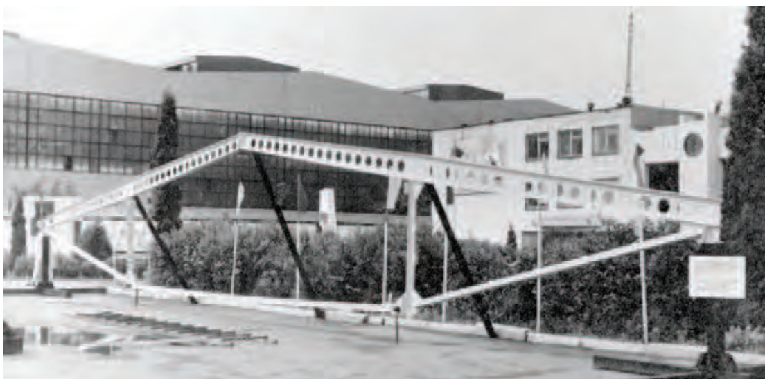
Рис. 2. Зовнішній вигляд малоелементної кроквяної ферми прольотом 18 м з перфорованим верхнім поясом змінної жорсткості
