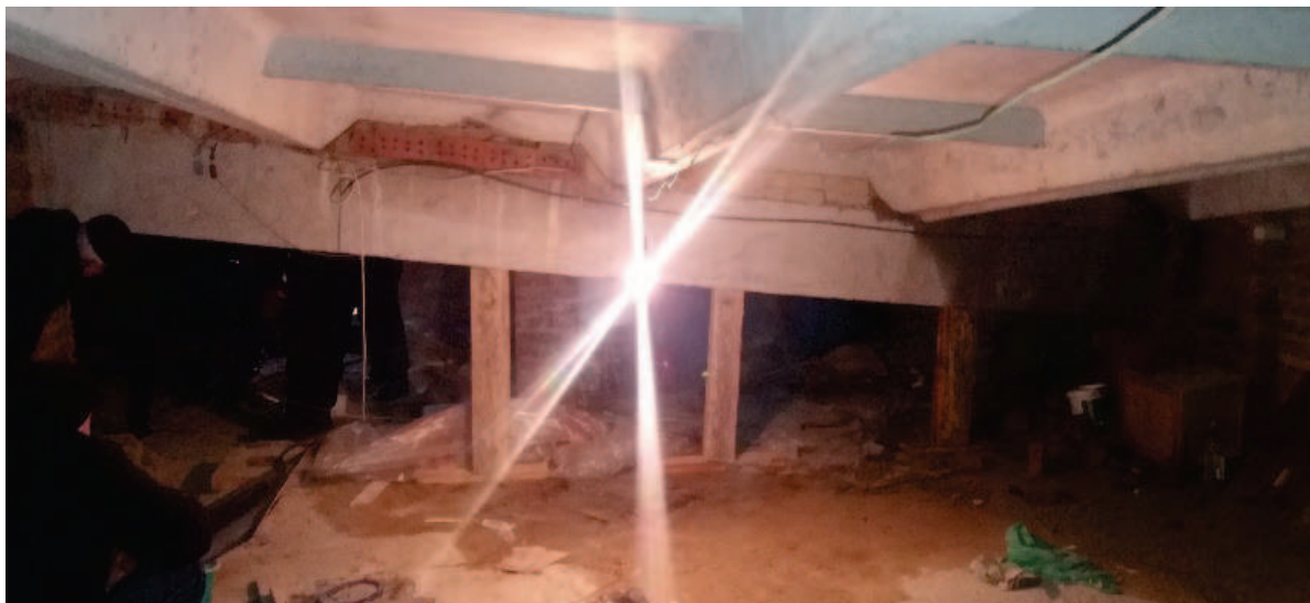
Рис. 2. Зміщення з проектного положення диску покриття
