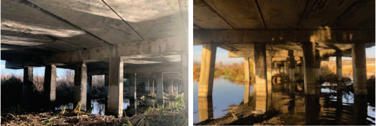
Рис. 2. Загальний вид моста, підмостовий простір.
