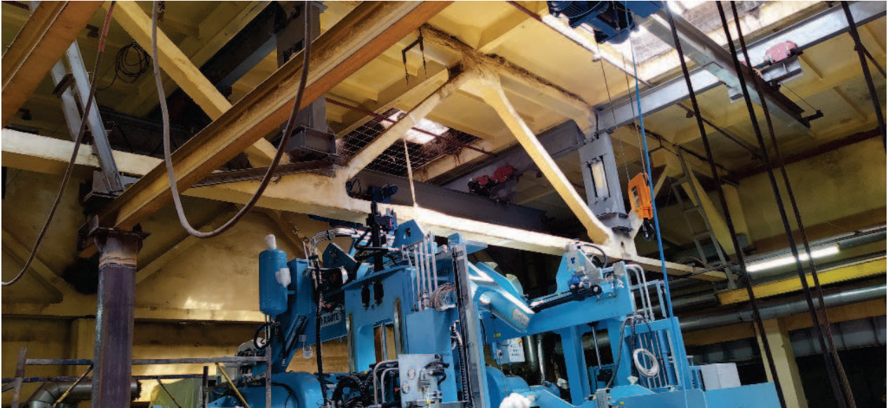
Рис. 7. Опорні вузли колон підсилення по фермі ФСП-2
