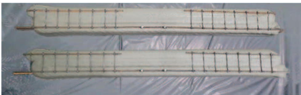
Рис. 4. Зварні арматурні каркаси по надрукованому четвертому шару
