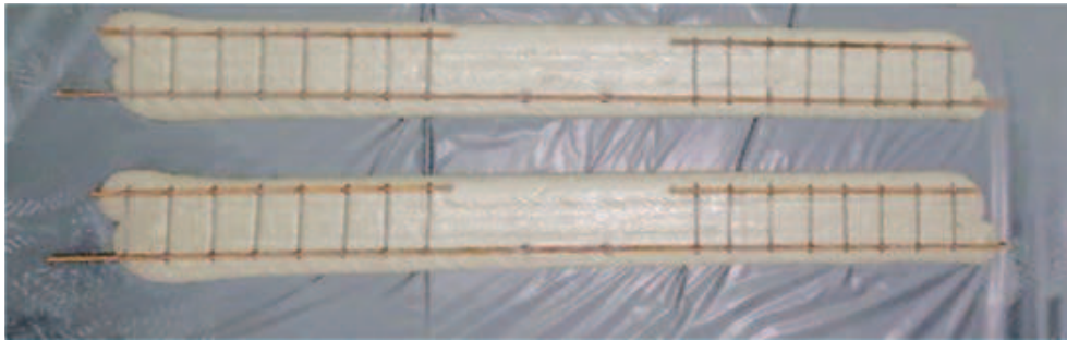
Рис. 3. Зварні арматурні каркаси по надрукованому першому шару
