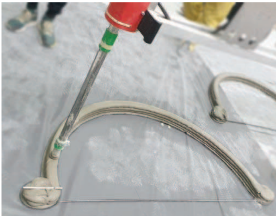
Рис. 4. Процес формування четвертого шару арочної конструкції
