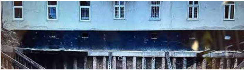
Рис. 1. Вид на влаштовану роз'єднувальну пальову стінку вздовж фасадної стіни по осі „А” обстежуваної будівлі
