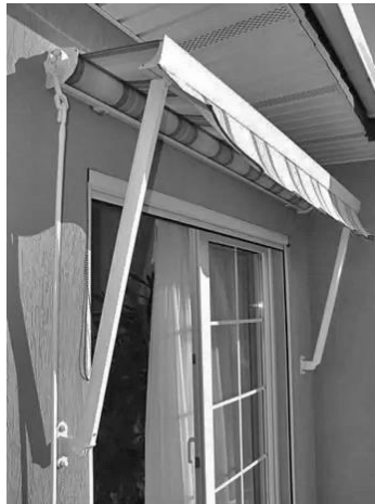
Рис. 4. Маркіза згортна з «падаючими ліктями» у згорнутому стані
