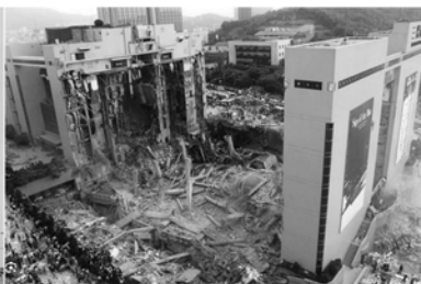
Рис 2 Будівля торгового центру після руйнування
