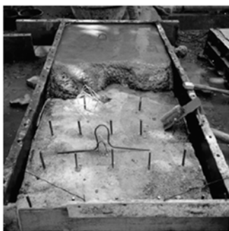
Рис. 5 Процес нарощення перерізу плити
