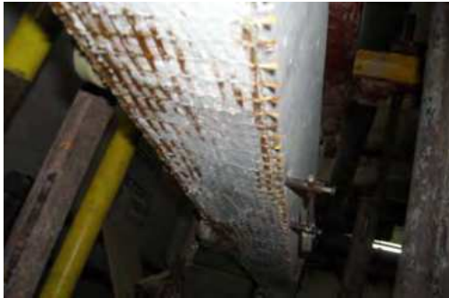
Рис. 1. Загальний вигляд підсилення залізобетонних балок системою Ruredil X Mesh Gold
