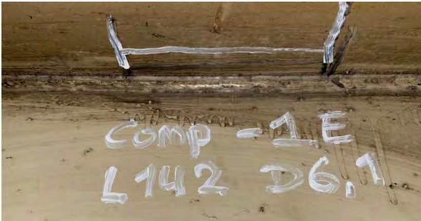
Рис. 1. Типові втомні тріщини в зоні з'єднання стінки та полицки сталевих підкранових балок
